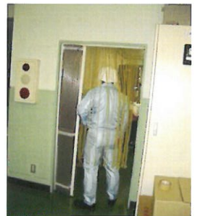
除電のれんをくぐる事により、溜まっている静電気を除去します
